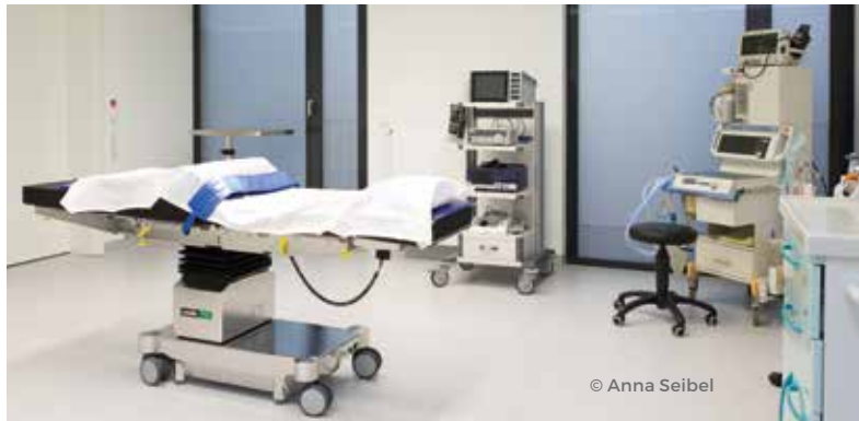
Neu erbauter und hochmoderner Operationssaal nach den hohen Standards der Medizin, um Sicherheit gewährleisten zu können.
