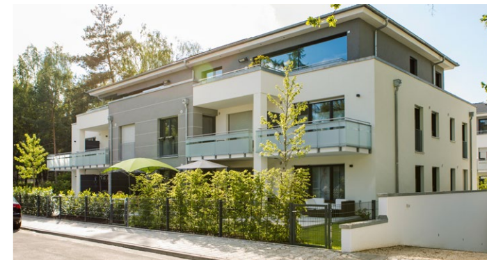
Wohnensembel in der Parkstraße in Schwaig b. Nürnberg, Fertigstellung 2017
