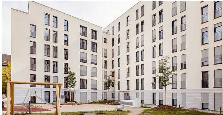
Neubau in zwei Bauabschnitten im Kleinreuther Weg in Nürnberg. Fertigstellung 2015 und 2016
